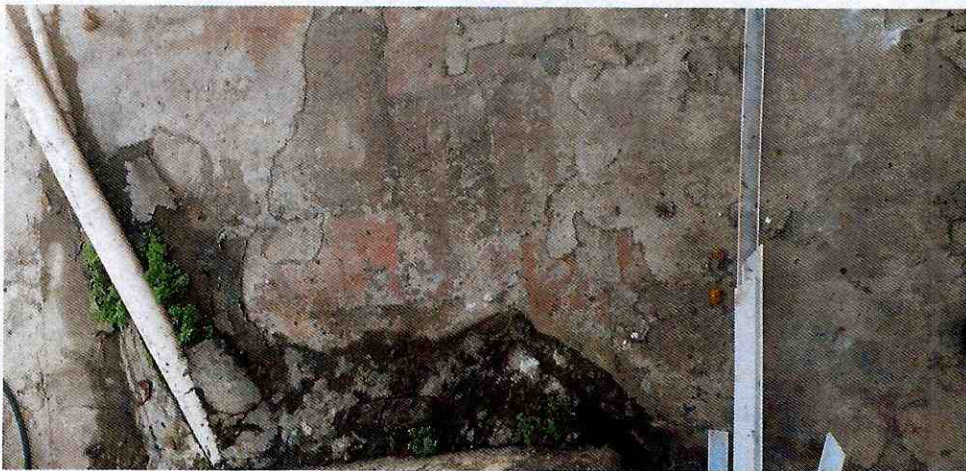
Techos con filtraciones y riesgos eléctricos
