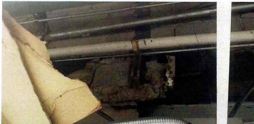
Paredes con bloques mal colocados sin terminación
